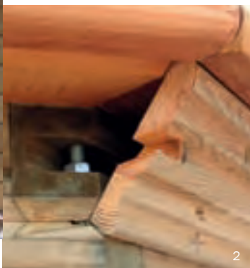
(1) Incastri a coda di rondine - (2) Supporto laterale
